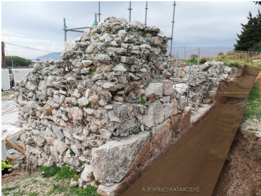
Εικόνα 4. Προτεινόμενα επίπεδα κατάχωσης στη βορειοανατολική γωνία του μνημείου. Η αντιστήριξη της υψομετρικής διαφοράς θα επιτευχθεί με τη χρήση συμβατού υλικού δόμησης (παρόλιθος).
